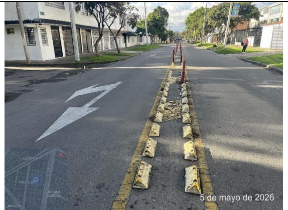
Foto No. 5 KR 22 con CL 86, vista al Norte.
