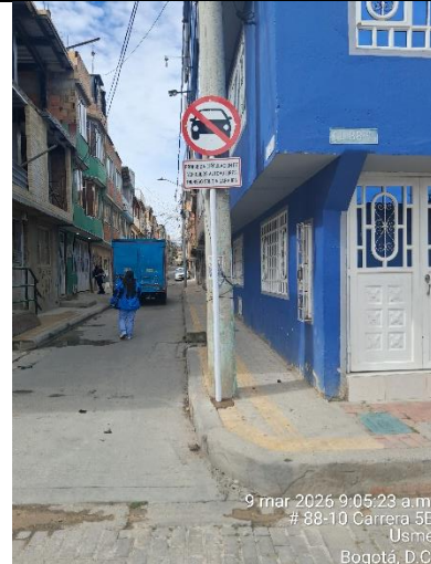
Foto 4. Implementación de señalización SR-16/ Plaqueta (Prohibida circulación de vehículos automotores/ Ingreso solo a garajes) en el sector de la KR 2B entre CL 88 S y 89 S, costado occidental. (DESPUÉS)
