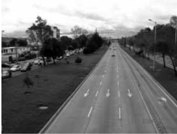
Fotografía 1.3 Vía principal arterial urbana Autopista norte
