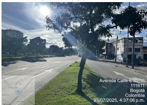
FOTO 1. CL 6 A LA ALTURA DE LA KR 31 VISTA AL OCCIDENTE
