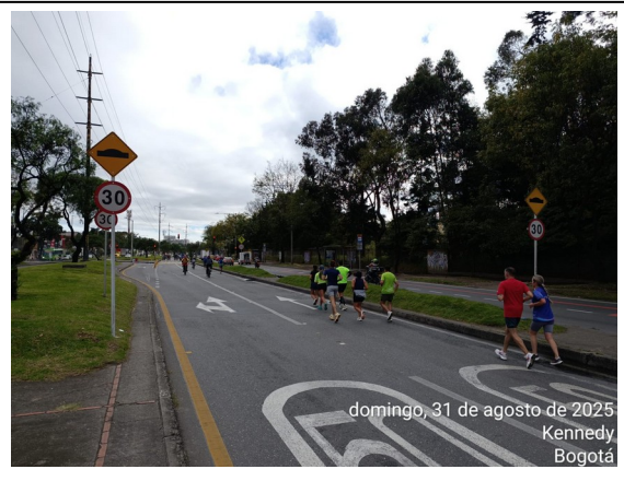
Foto 24. Panorámica Av. Boyacá entre Av. 1 de Mayo y CL 12, vista al Norte.
