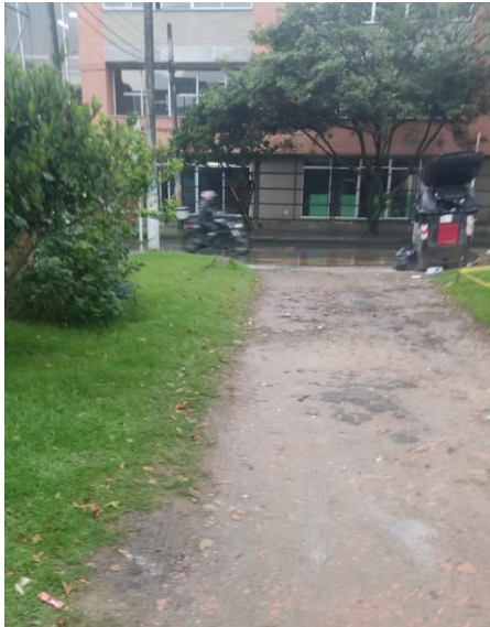
Foto 11. deterioro Parque Muzu
