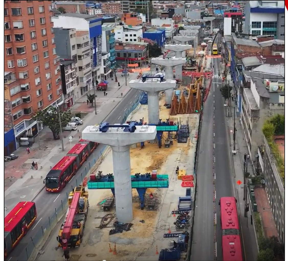
WF6 – Superestructura. Viga Lanzadora DENIS. Proceso de armado Av. Caracas Apoyos S16-01
