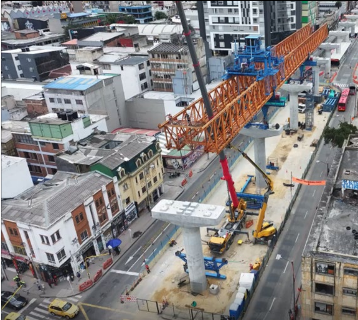
WF6 - Superestructura. Viga Lanzadora CAMILA. Proceso de armado Av. Caracas Apoyo S15-50
