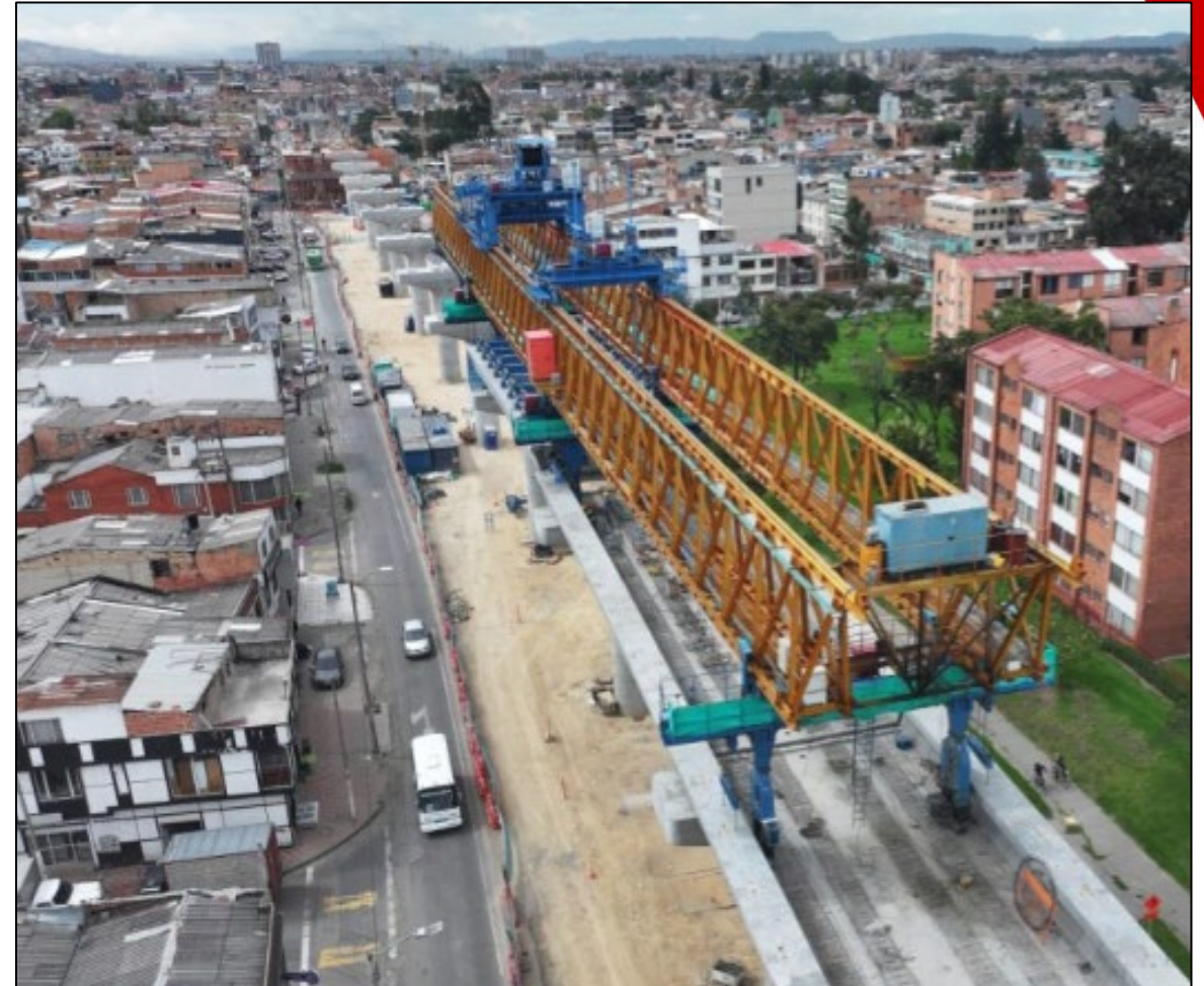
WF-3 Superestructura. Viga Lanzadora GLORIA (#7) vano S9-8
