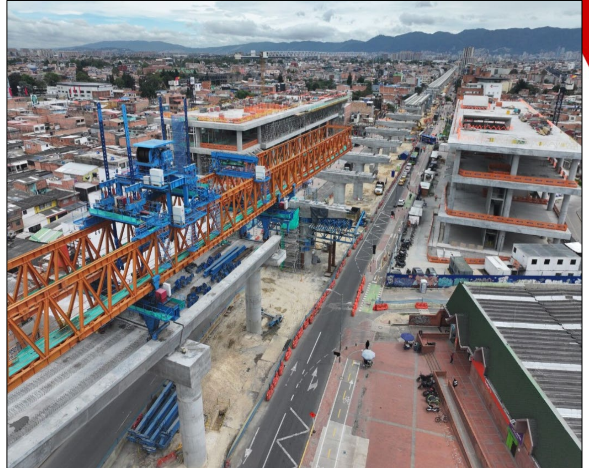
WF2 – Superestructura Viga Lanzadora BELLA - Interestación 4, sentido hacia Calle 72
