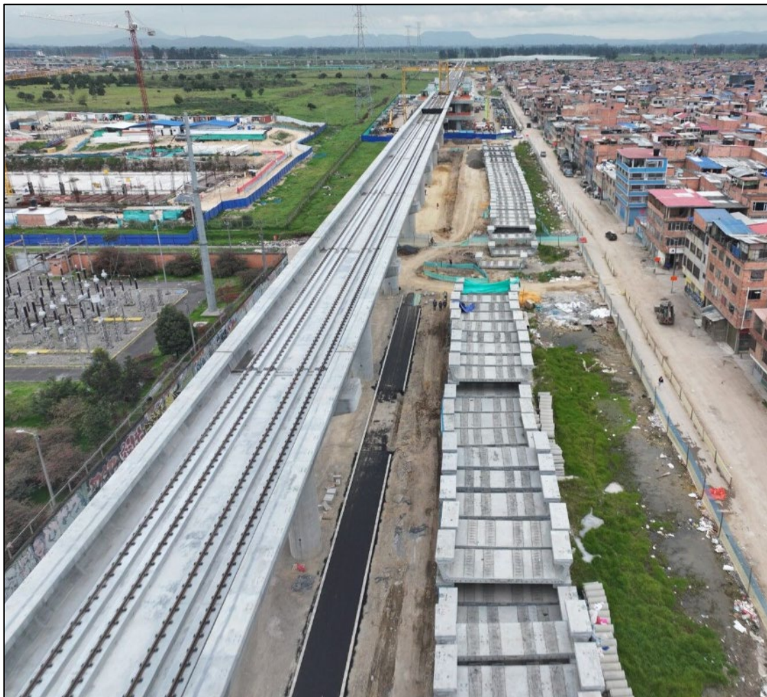
WF1 - Interestación 2 Ejecución 100% Subestructura y Superestructura
