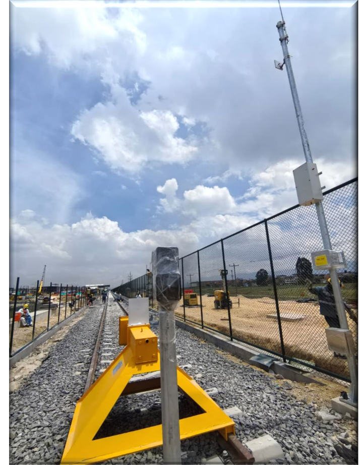
Instalación de elementos de campo del Sistema de Señalización y Control de Trenes (señales, radios CBTC)
