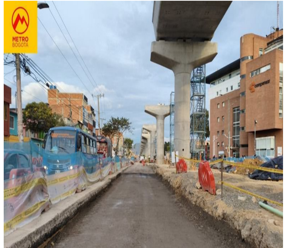
WF2- Interestación 5 Construcción estructura de pavimento, S5-01 al S5-23
