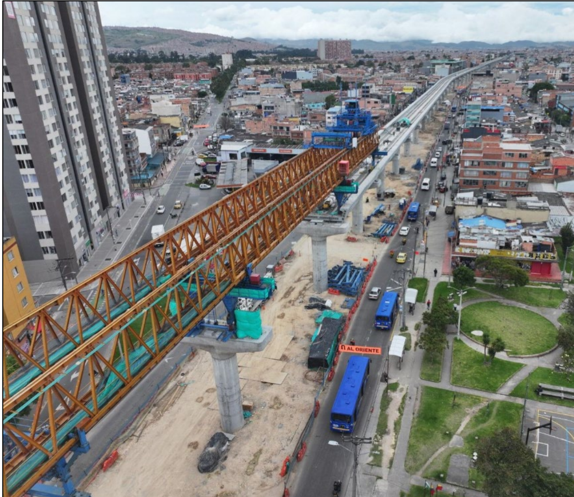
WF2 – Superestructura. Viga Lanzadora FABIOLA - Interestación 6. Vano S6-19
