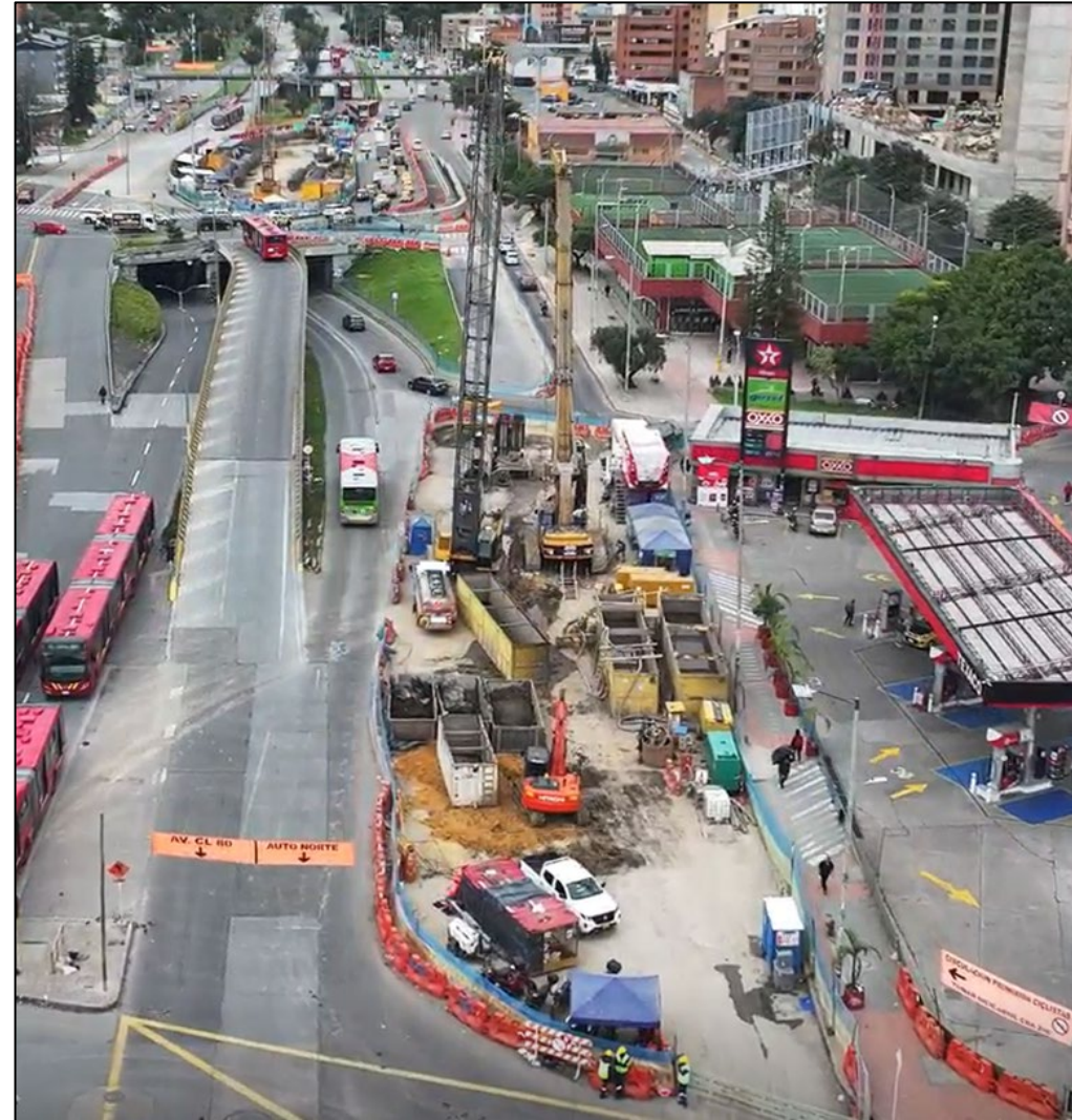
WF6 - Calle 76 hasta Calle 80
