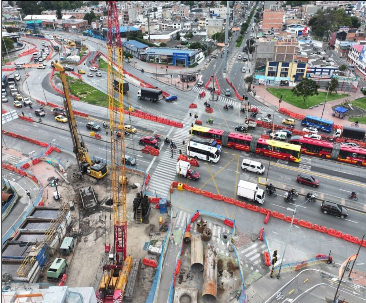
WF4 - Interestación 10. Av. NQS hacia la calle 8 sur
