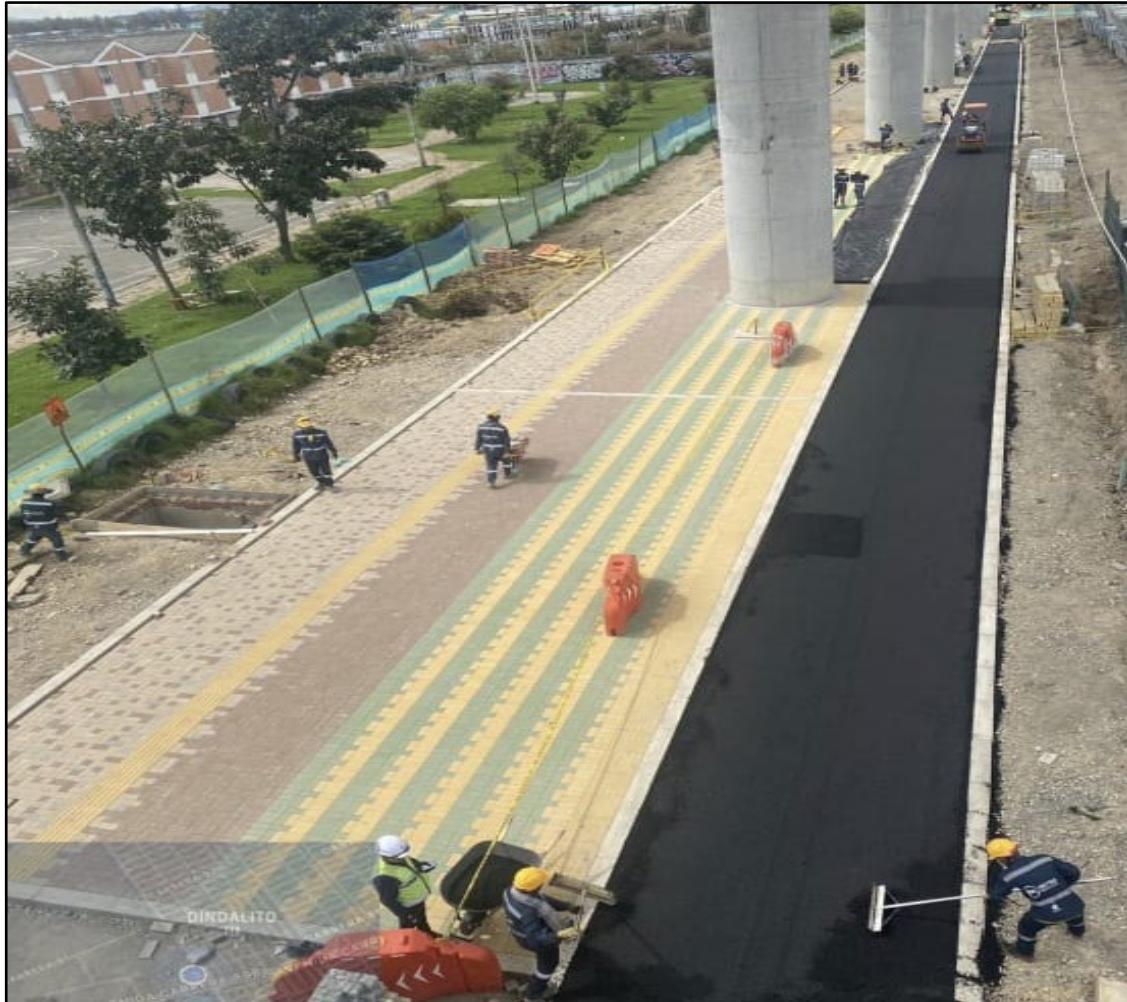
WF1- Interestación 2 Construcción espacio público, S2-06 al S2-12
