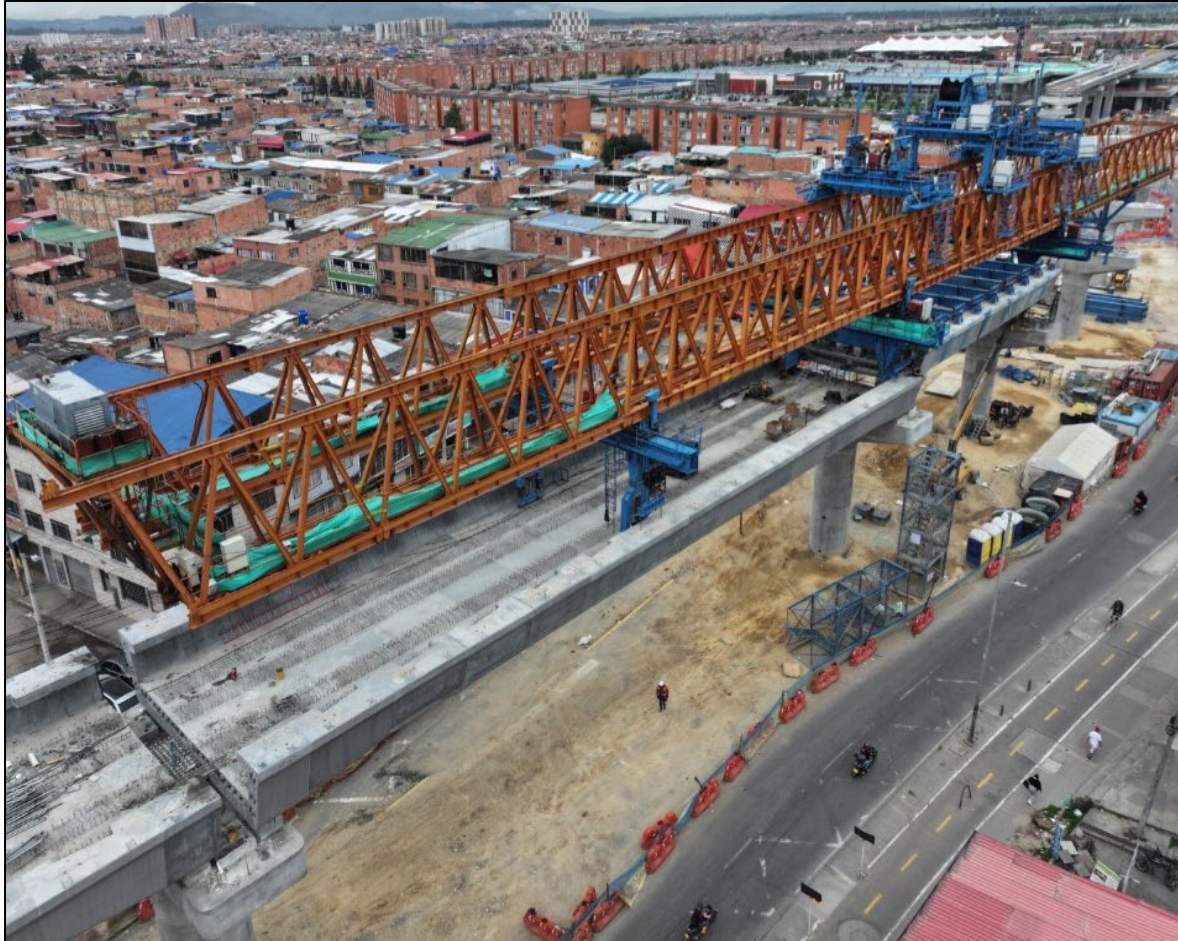
WF1 - Superestructura Viga Lanzadora ANA –Interestación 3, Sentido hacia Patio Taller
