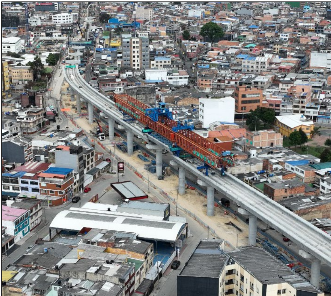
WF - 4 Superestructura. Viga Lanzadora HELENA. Proceso de instalación vano S10-42)
