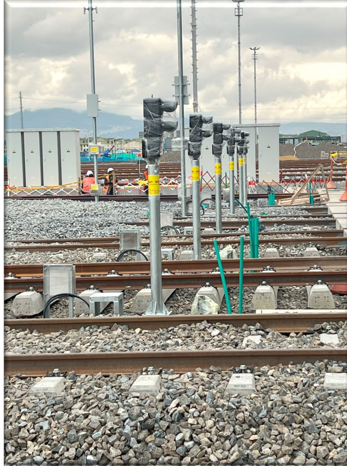
Instalación de elementos de campo del Sistema de Señalización y Control de Trenes (señales, radios CBTC)
