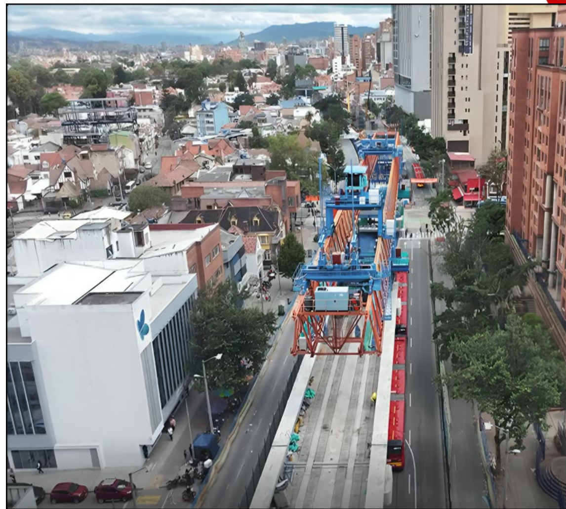
WF5 – Superestructura. Viga Lanzadora EMILIA. Av. Caracas instalación de dovelas vano S14-18
