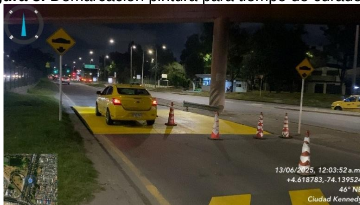
Figura 3. Demarcación pintura para tiempo de curado de resalto
