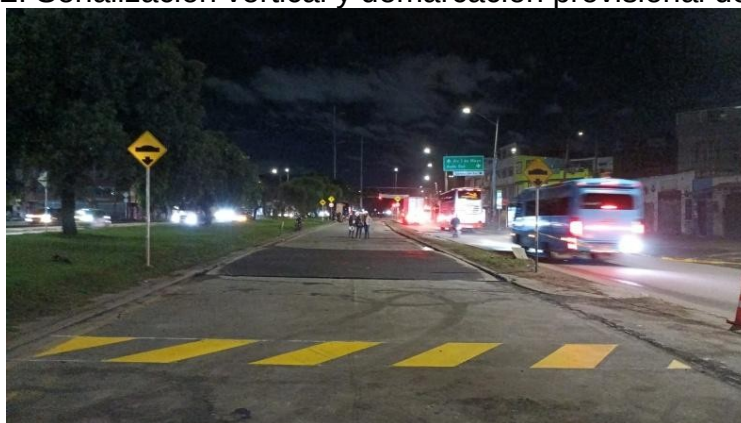
Figura 2. Señalización vertical y demarcación provisional del resalto
