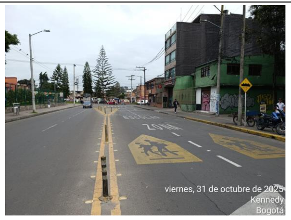
Foto 6. Panorámica KR 79A con CL 36 Sur, vista al Occidente.
