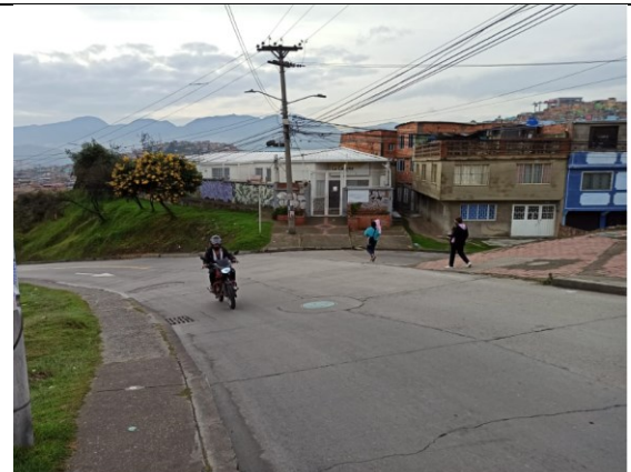
Fotografía 6. Falta de reductores de velocidad en la Carrera 20 C.
