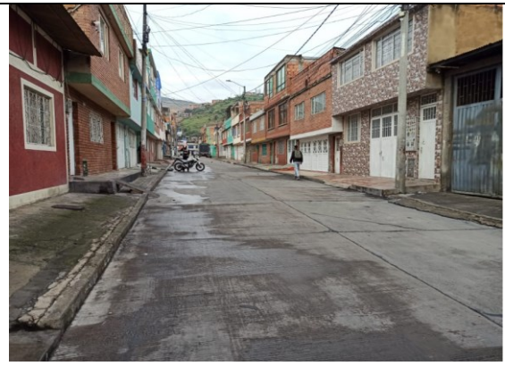
Fotografía 2. Falta de señalización horizontal y vertical en la Carrera 21ª.
