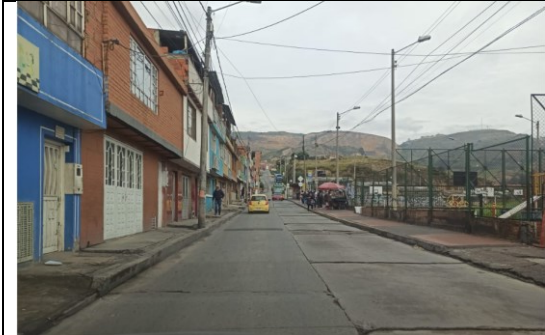
Fotografía 3. Deterioro en la malla vial y falta de señalización en la Carrera 20 C.
