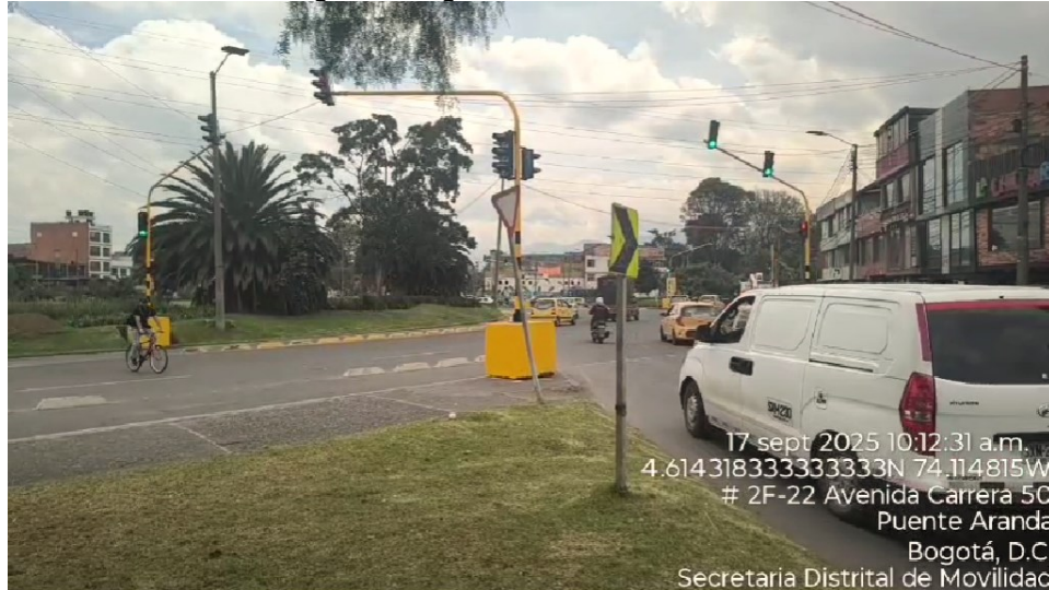
Registro fotográfico Costado Sur AK 50
