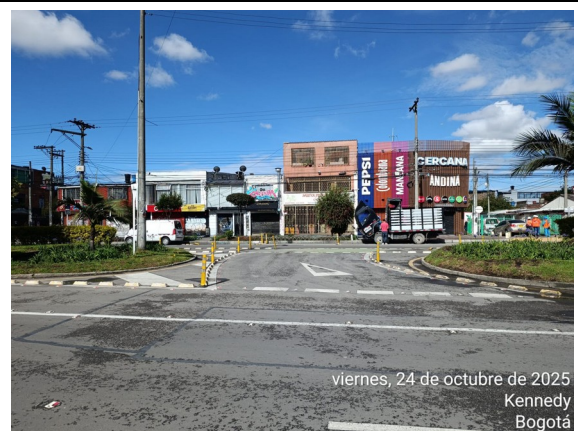
Foto 2. Panorámica KR 71D entre CL 3 y 3 Sur, vista al Occidente.
