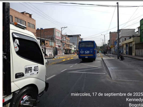
Foto 8. Panorámica KR 79 entre CL 38C Sur y 40C Sur, vista al Norte.
