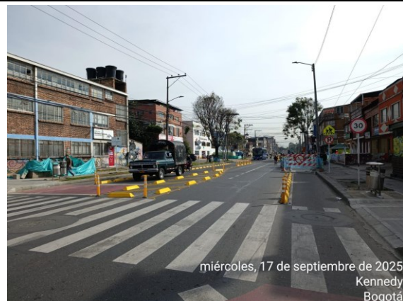
Foto 12. Panorámica KR 79 entre CL 38C Sur y 40C Sur, vista al Norte.
