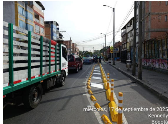
Foto 10. Panorámica KR 79 entre CL 38C Sur y 40C Sur, vista al Norte
